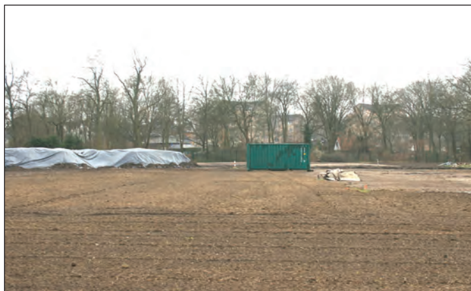
Noch sieht es wenig einladend aus, doch ein Container und mit Planen abgedeckte Erdhaufen zeigen schon an, dass im Waldgarten bald Bauarbeiten beginnen.
