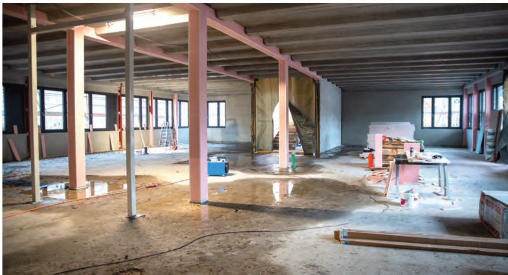
Schilling-Schule Rohbau ist fristgerecht fertiggestellt. Große Fensterfronten schaffen lichte Räume.
